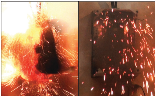
Figura B. Durante la prueba de aplicación incorrecta (gabinete 1)
